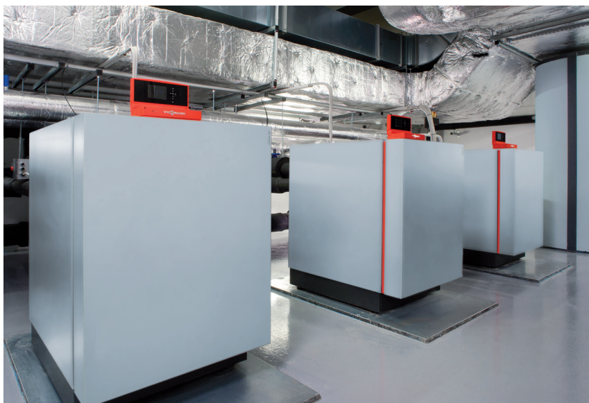
Brine/vand-varmepumpen Vitocal 300-G Varmeydelse enkelttrins: 21,2 til 42,8 kW, totrins: 42,4 til 85,6 kW maksimalt 428 kW (som kaskade)
